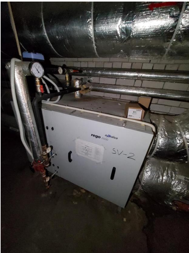
Ventilatsiooniagregaad ja kaugküttesõlm
